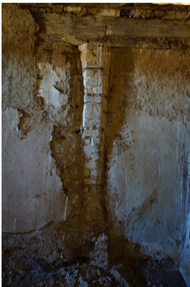
Figura 13. Pilar empotrado en el muro sur. 2020. Imagen del autor.
