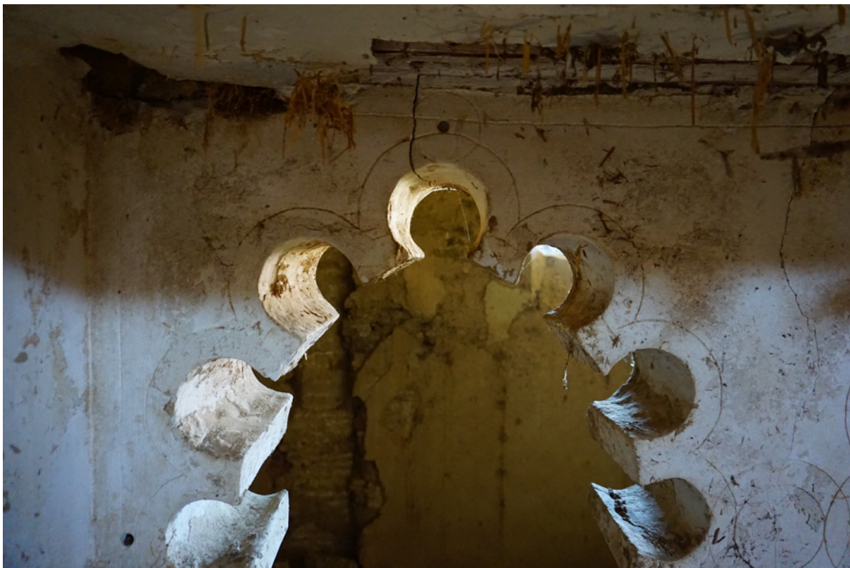
Figura 8. Ventana oeste, detalle interior. 2020. Imagen del autor.
