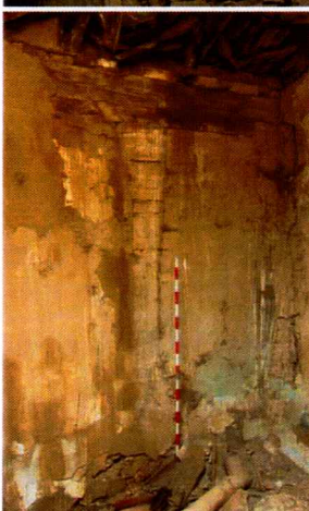
Dependencia derecha de la primera cruzía. La ruina del tejado y el efecto del agua de lluvia ha dejado al descubierto la primera ventana geminada de arcos polilobulados. Encastrados en el muro sur o de fachada al exterior se observan los restos de sendos pilares ochavados de ladrillo que harían la función de pórtico.
