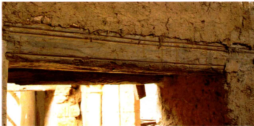
Puerta de acceso a la dependencia exterior, en la que se reutilizaron maderas gramiladas procedentes seguramente de una estructura de cubierta
