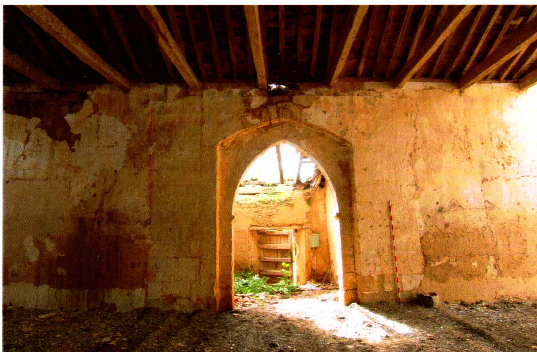
Interior de la crujía del palacio hacia la puerta de acceso
