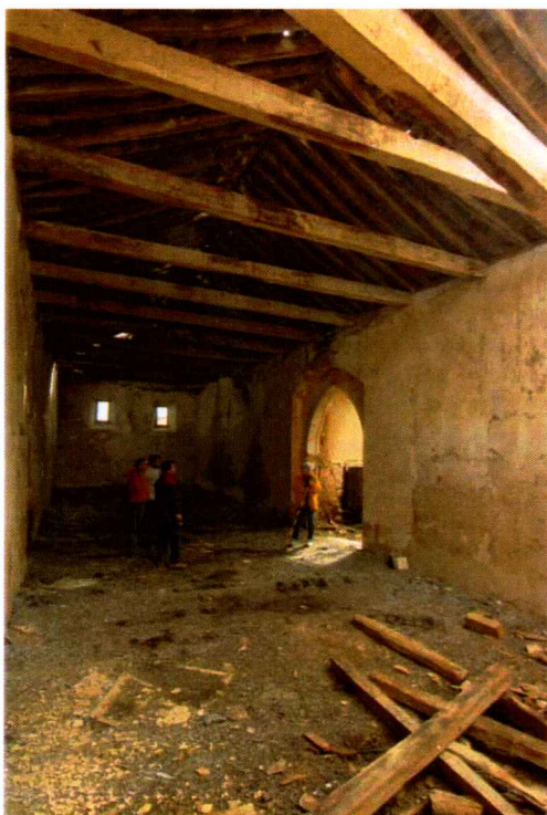
Lamentable situación de la crujía interior del palacio: suelo lleno de excrementos y alarmante estado de la armadura de cubierta, de la que se ha arruinado la parte Oeste
