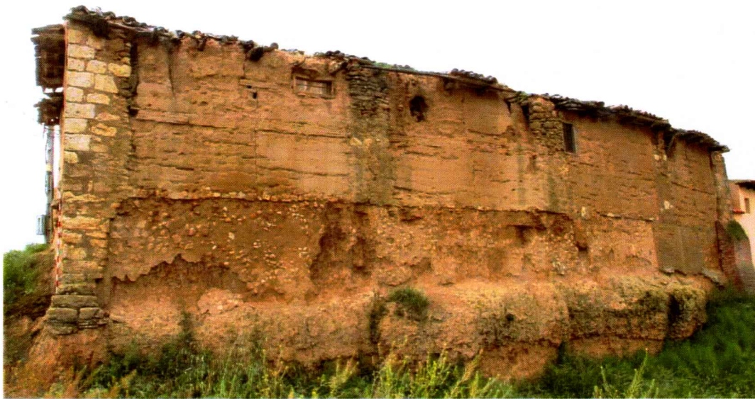
Lateral y muro Norte de la panera (Calle de la Cuesta)
