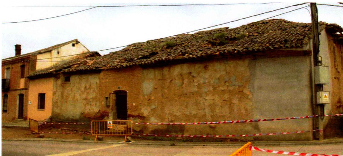
Aspecto exterior de la panera y puerta de acceso
