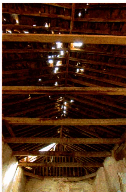
Lamentable situación de la crujía interior del palacio: suelo lleno de excrementos y alarmante estado de la armadura de cubierta, de la que se ha arruinado la parte Oeste
