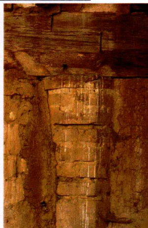
Dependencia derecha de la primera cruzía. La ruina del tejado y el efecto del agua de lluvia ha dejado al descubierto la primera ventana geminada de arcos polilobulados. Encastrados en el muro sur o de fachada al exterior se observan los restos de sendos pilares ochavados de ladrillo que harían la función de pórtico.
